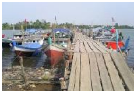
Sumber : Survey Lapangan
