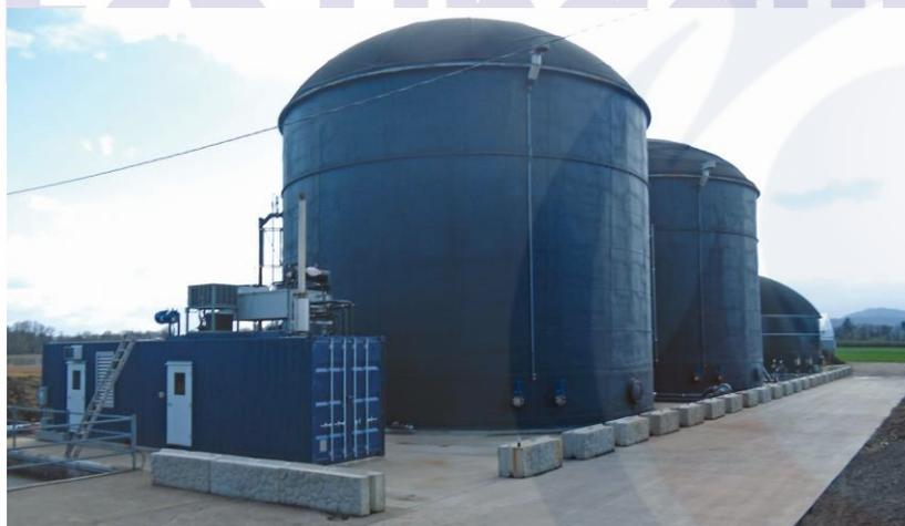
Gambar 4. Fermentor untuk reaksi anaerob (sumber: <https://www.biocycle.net/>).
