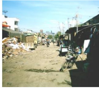
Gambar 1. Jalan Rawa Bebek Jl. Rawa Bebek memiliki kondisi buruk (tidak beraspal) dengan ROW 8, arus lalu-lintas 2 (dua arah) dan merupakan akses utama ke lokasi kolong tol.
