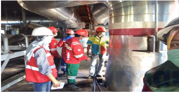
Pekerjaan Pemasangan Pisa Uap di Belt Conveyor
