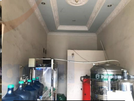
Kondisi atap dan dinding
