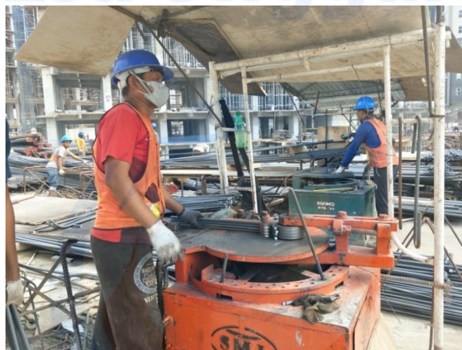
Salah satu pekerja pada proses bar bender
