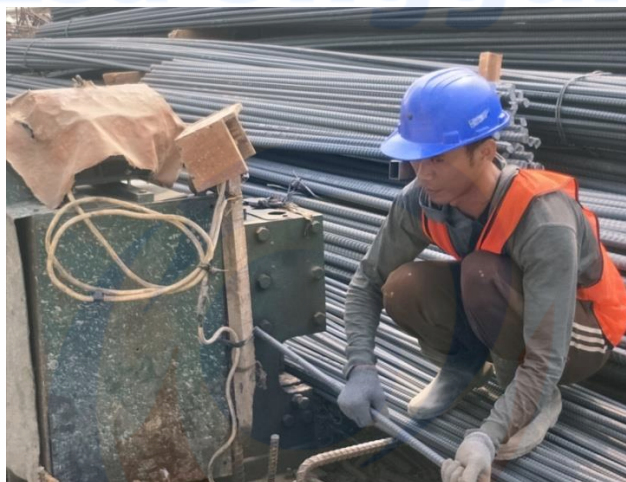
Salah satu pekerja pada proses bar cutter
