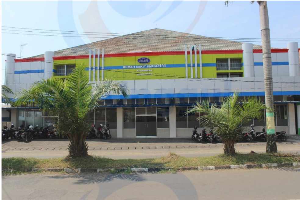
Gambar L.1 Gedung Rumah Sakit MM Indramayu
