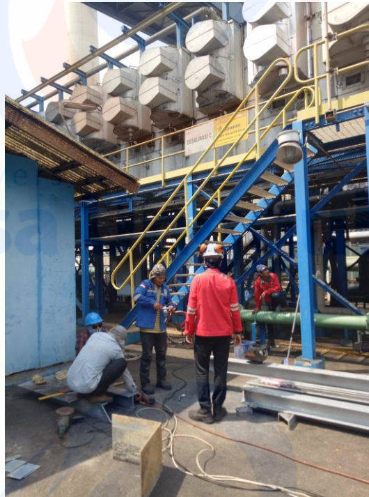
Gambar 4. Menegur pekerja yang tidak menggunakan APD lengkap di unit Desalination Plant
