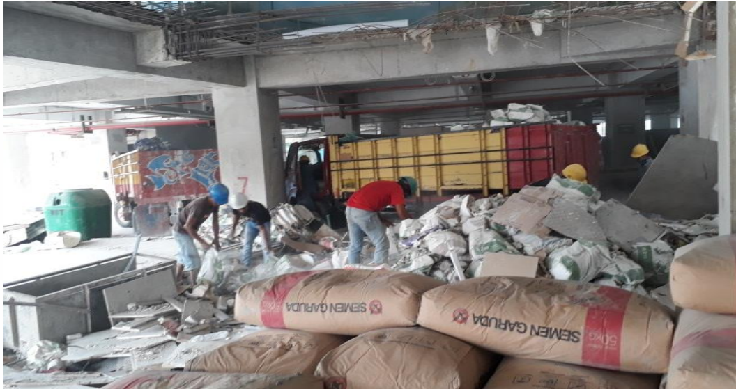
Proses pemindahan hasil puing proyek ke truk
