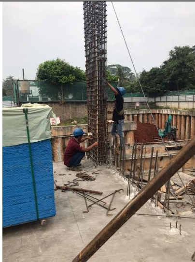
Pekerjaan Bekisting pada Lantai 3
