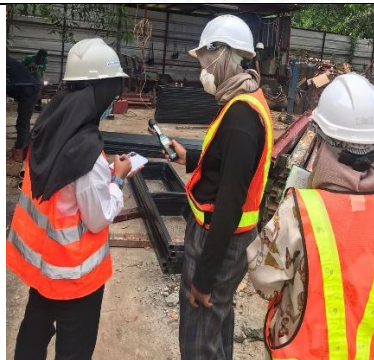
Pengecekan Kebisingan dengan Sound Level Meter
