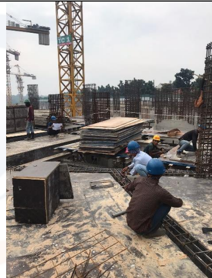
Pekerjaan Balokan pada lantai 3
