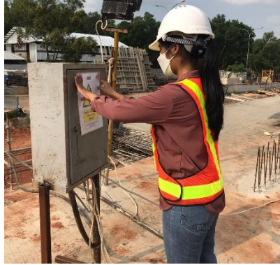
Pemasangan Sign Board Pada Area Berisiko
