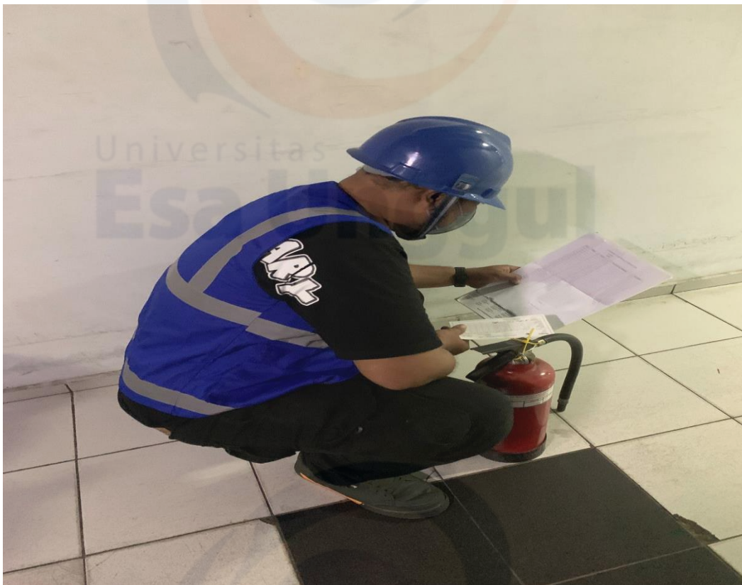
Gambar 6: Ceklis pengecekan Tabung APAR
