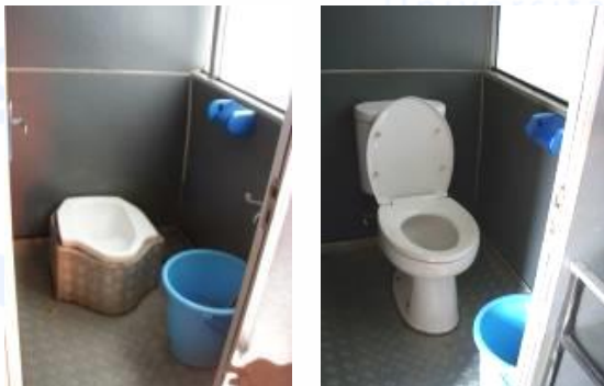
Gambar 13. Kloset jongkok dan duduk pada mobil toilet VIP Sumber data: Irma Damayantie, 2018
