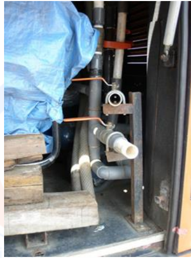
Gambar 23. Pemipaan mobil toilet VIP Sumber: Dok. Irma Damayantie, 2018
