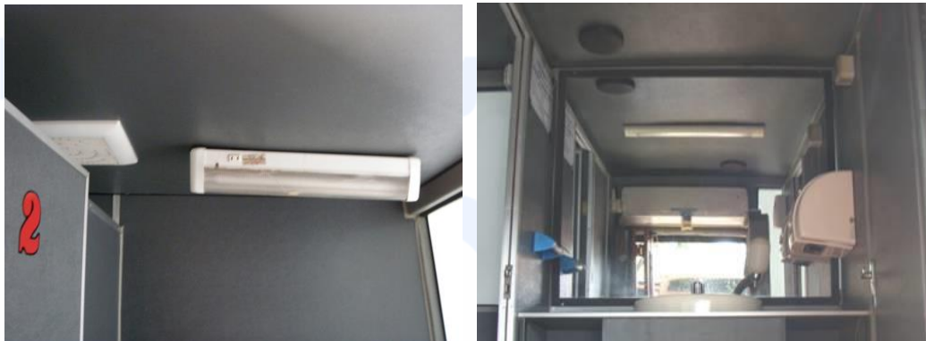
Gambar 24. Pencahayaan mobil toilet VIP Sumber: Dok. Irma Damayantie, 2018
