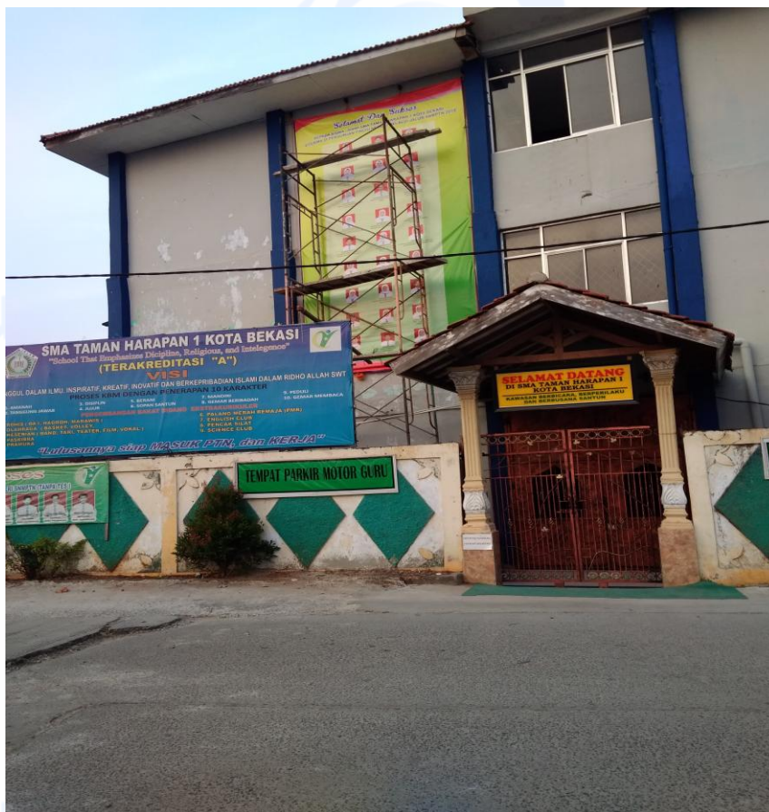
Gambar 1.1. Bangunan Tampak Depan SMA Taman Harapan 1 Kota Bekasi
