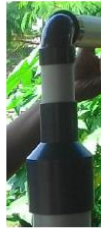
Sambungan Pipa Ke Tong Air
