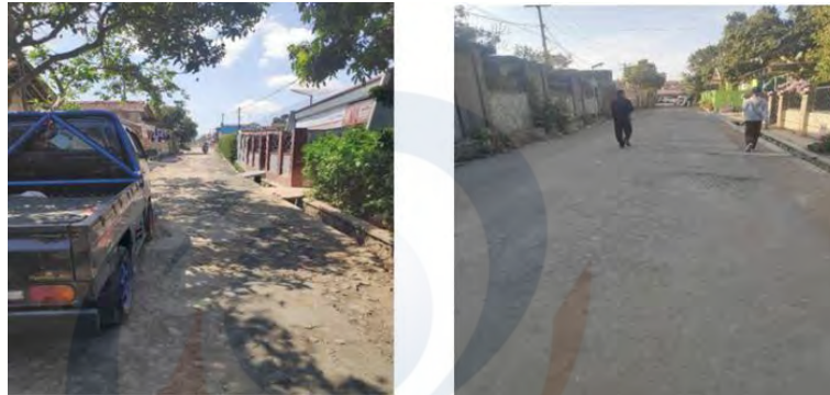
Gambar 3.3 Jalan Desa Balewangi
