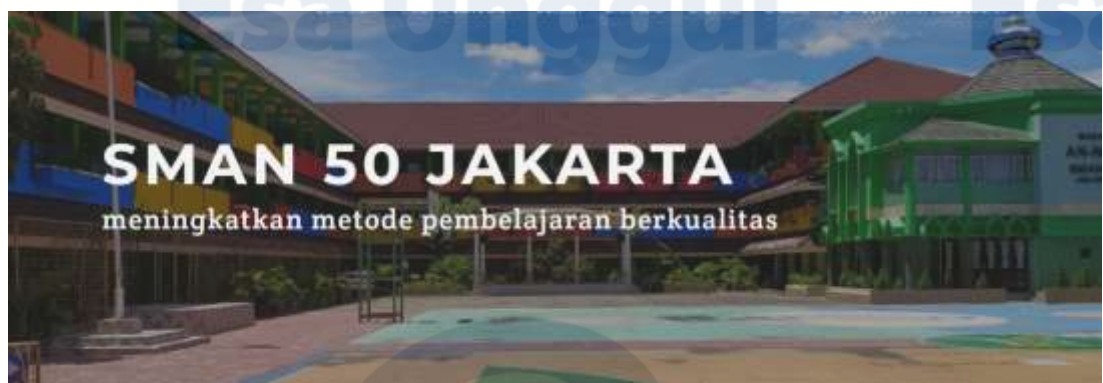
Gambar 2. Kondisi dan situasi SMAN 50 Jakarta
