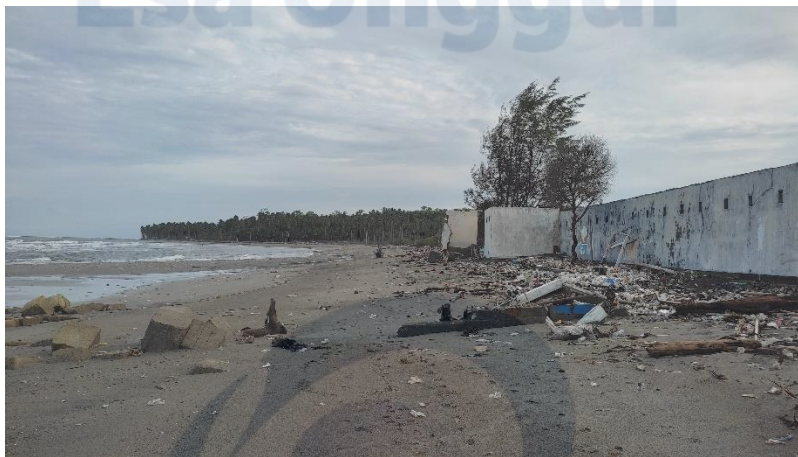
Gambar 8. Kerusakan Fasilitas Kampung Penyu Akibat Abrasi.
