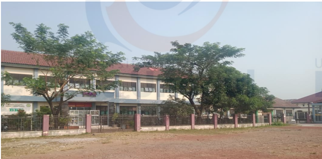
Gambar 1.1 Kondisi SMKN 12 Kabupaten Tangerang
