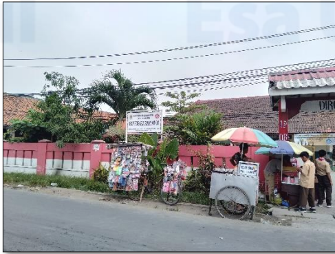
Gambar 2. Bangunan sekolah yang terletak di pinggir jalan
