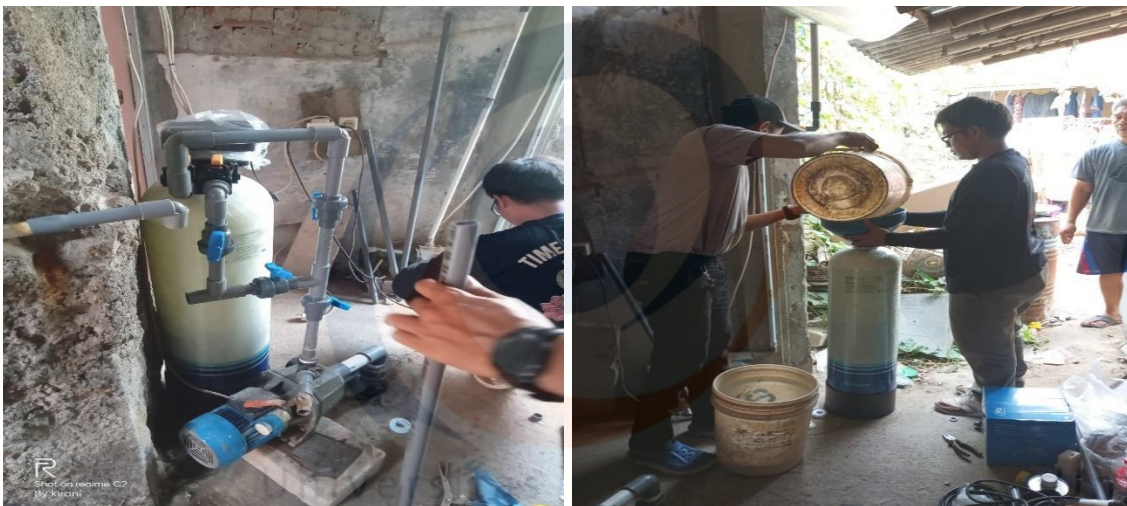
Gambar 11 : Pemasangan Mesin Filter Air Bersih di Lokasi Mitra
