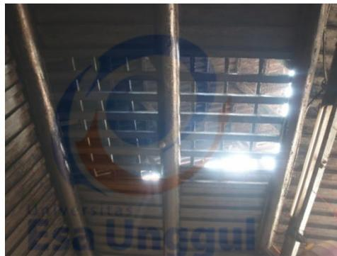
**Gambar 10. Plafon Mengikuti Konstruksi Atap**
