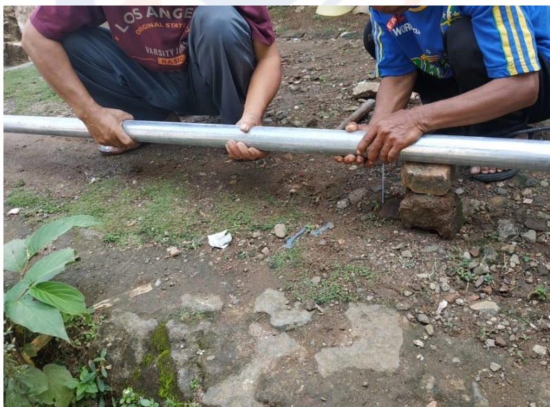
Gambar Lampiran 11 Penyambungan Tiang Galvanis
