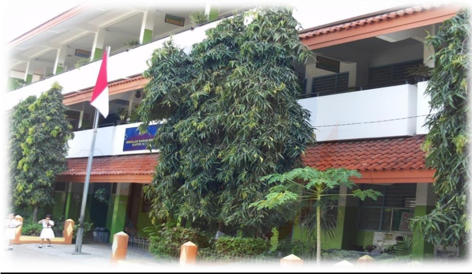
Gedung SDN Kapuk 15 Pagi
