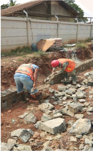
Proses pemasangan batu kali
