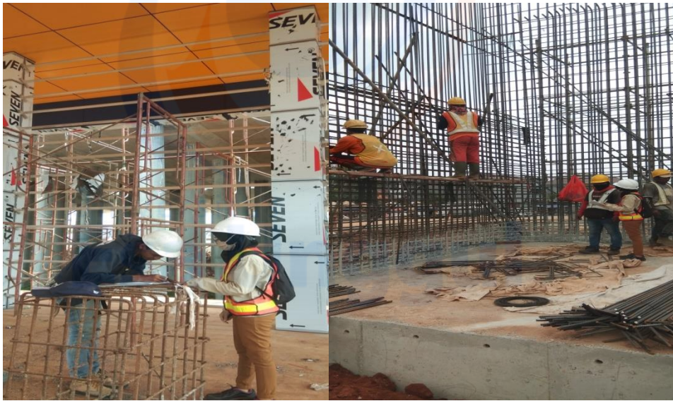
Observasi penyebaran kuesioner dan wawancara kepada pekerja di PT Wijaya Karya Proyek Pembangunan Jalan Tol
