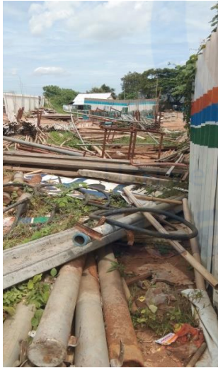
Kondisi area lingkungan Samping klinik
