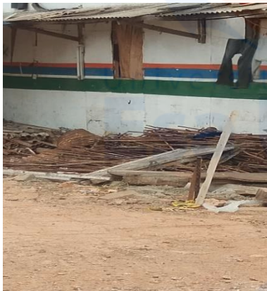
Kondisi area lingkungan depan mess tempat tinggal
