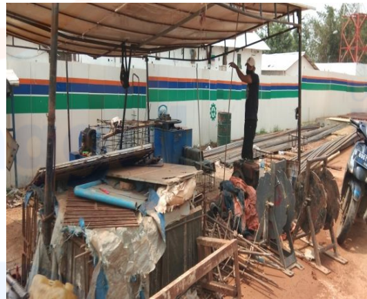
Proses perakitan kerangka besi untuk proses pemasangan besi abutment
