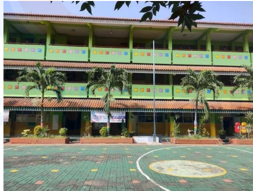
Gedung Sekolah Duri Kepa 05
