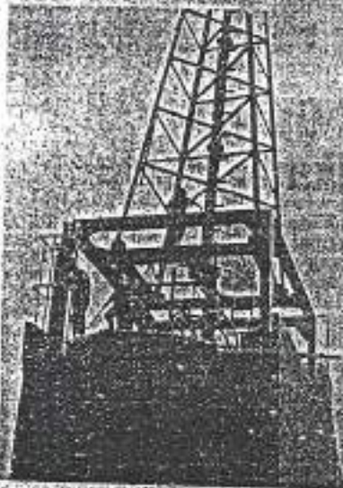
Petugas Sudin Penataan Kota Jakbar merobohkan menara seluler tidak punya izin di Pegadungan.
